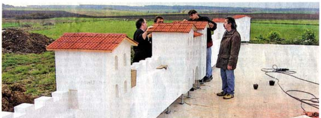
Gegenwärtig wird das Modell, das von der AWO-Therapiewerkstatt in Cronheim gebaut wird, an Ort und Stelle aufgebaut.
